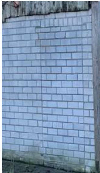
Materiaalgebruik gevelbekleding bijgebouw kalkzandsteen metselwerk
