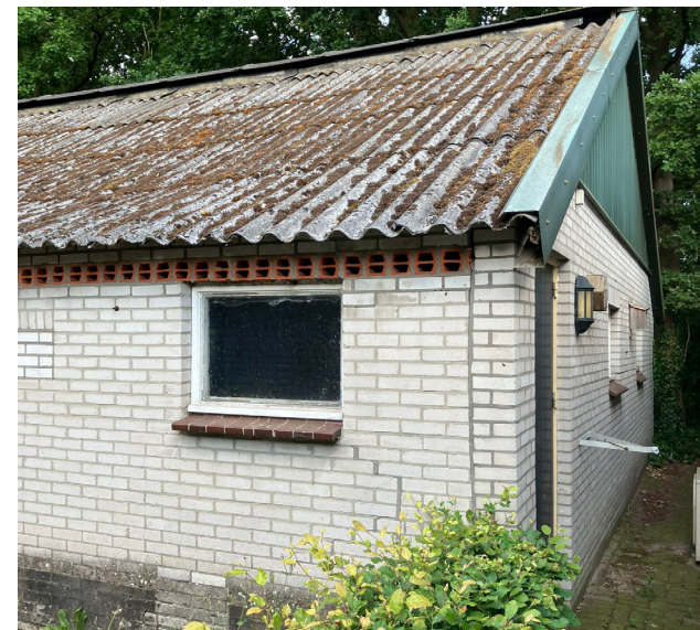
Beeld 13. Bestaande oude schuur achter boerderij
