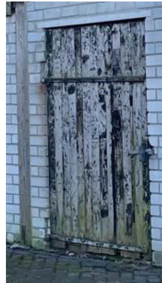
Stalramen en -deuren karakteristiek voor bijgebouwen
