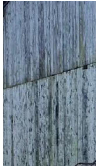
Materiaalgebruik gevelbekleding bijgebouw verticale donkere planken
