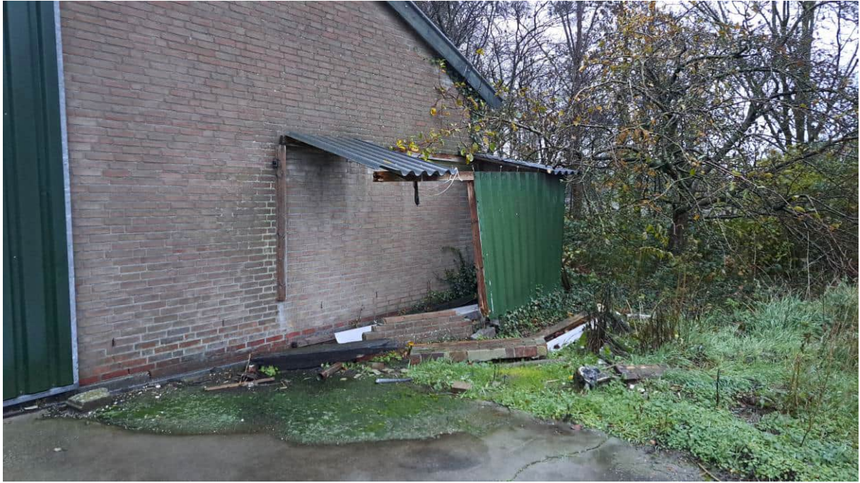
Locatie voormalige dieseltank
