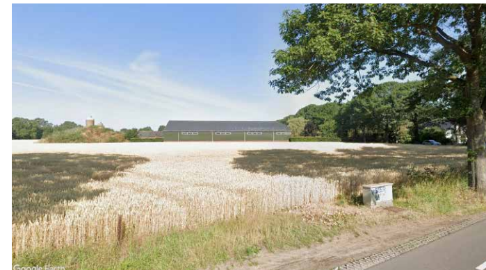
Figuur 18. Zicht op loods vanaf Loosbroeksestraat thv huisnr. 7 (foto: Google-Streetview)
