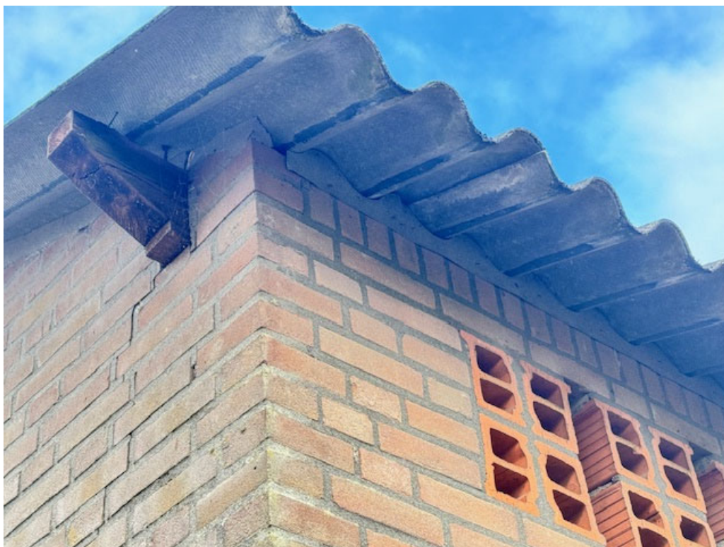
• Afbeelding 24: onderzijde golfplaten te slopen stal
