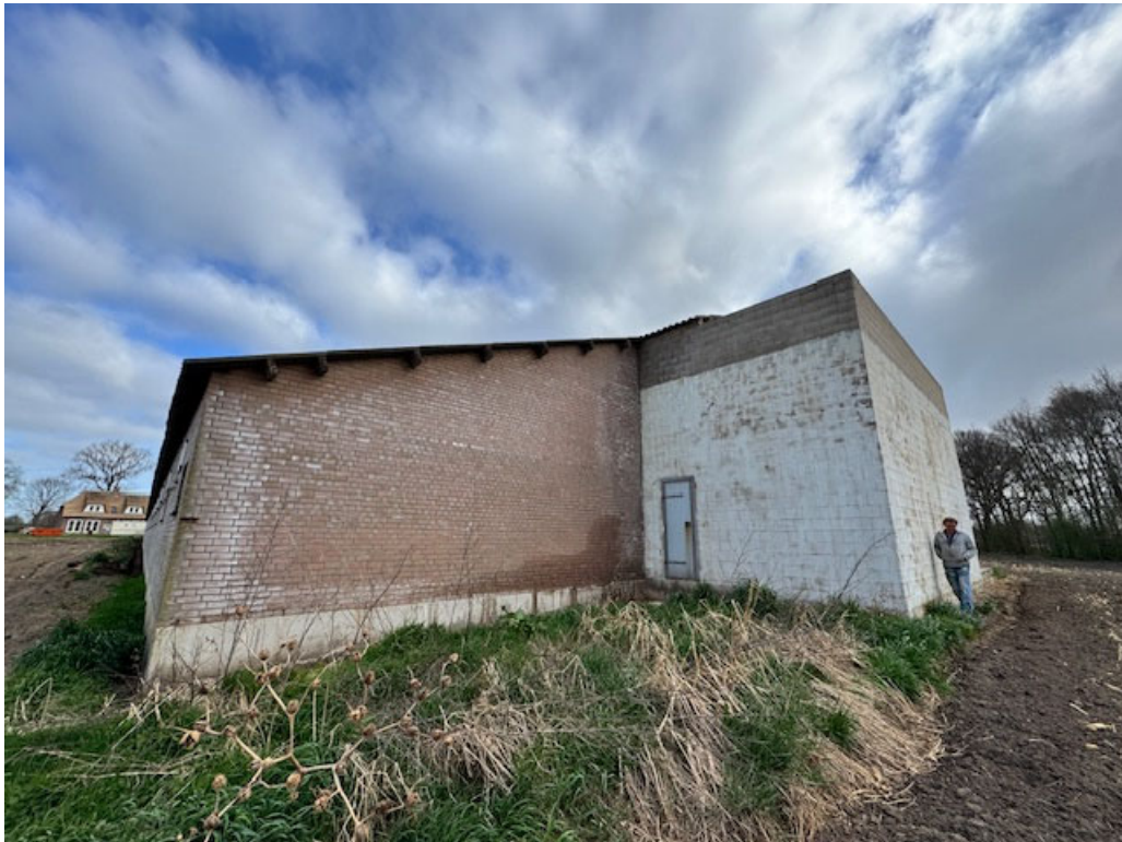
• Afbeelding 28: luchtwasser wordt verwijderd
