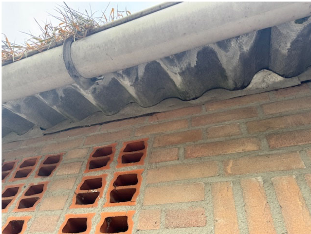
• Afbeelding 14: onderzijde golfplaten te slopen varkensstal
