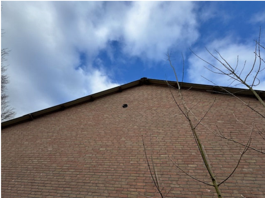
• Afbeelding 20: achterzijde te slopen stal
