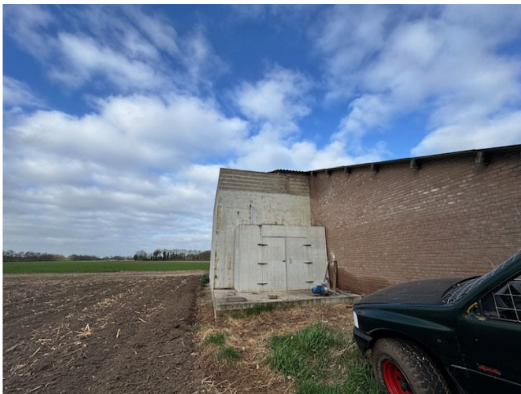
• Afbeelding 26: te verwijderen luchtwasser
