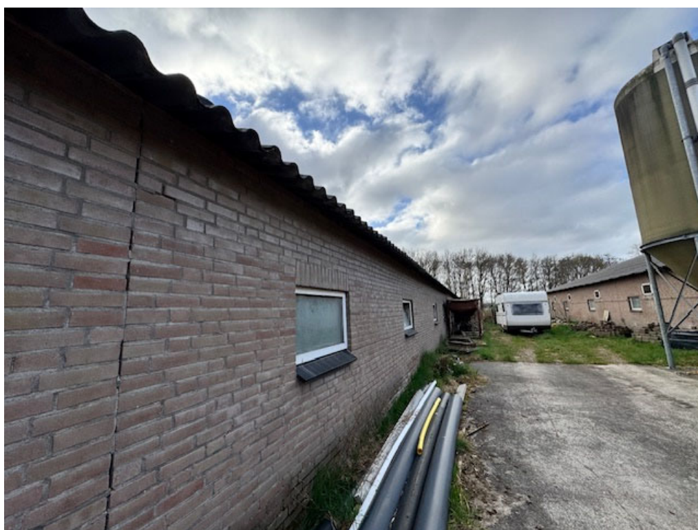
• Afbeelding 25: stal wordt gesloopt vanaf dilatatievoeg, voorste deel blijft staan
