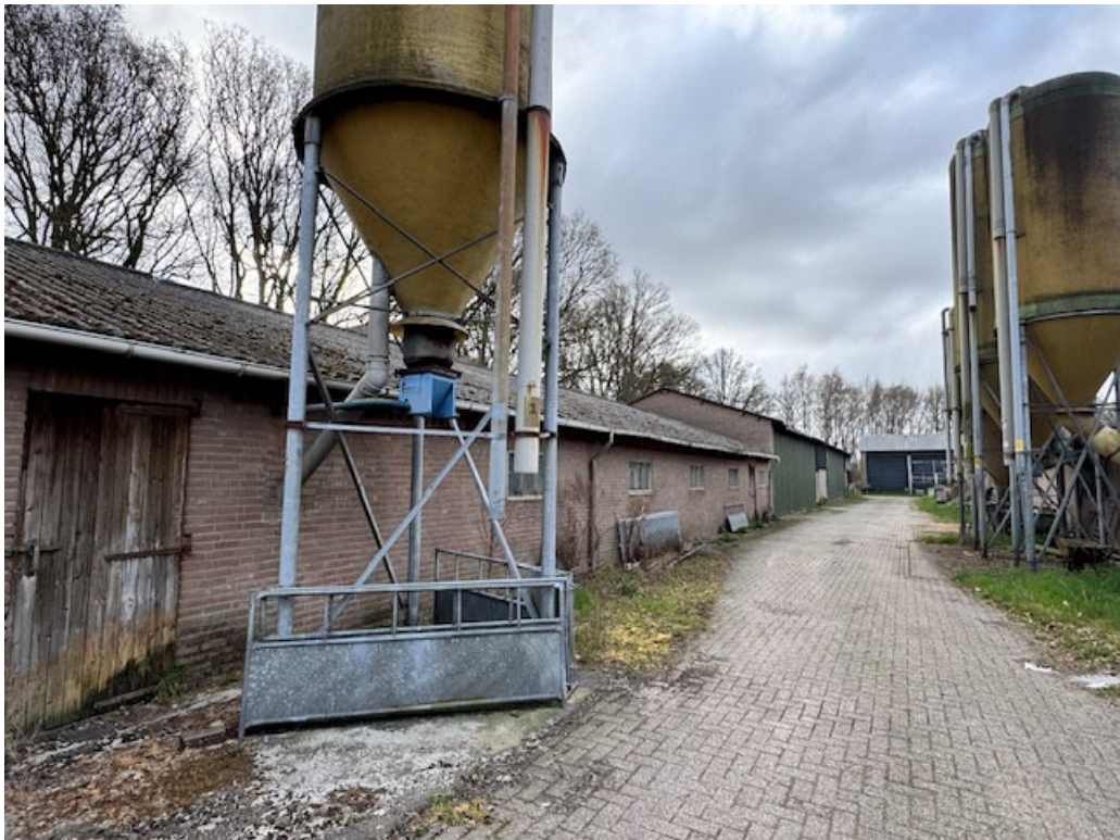
• Afbeelding 7: stal wordt gesloopt tot aan de groene damwand
