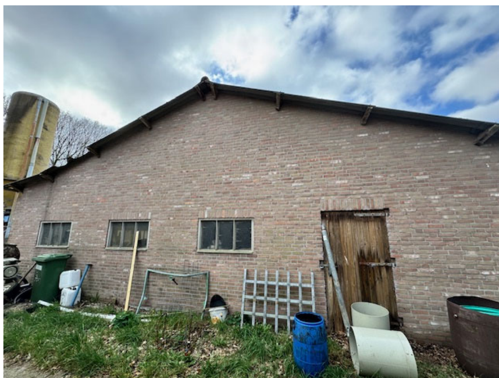
• Afbeelding 11: voorgevel te slopen varkensstal
