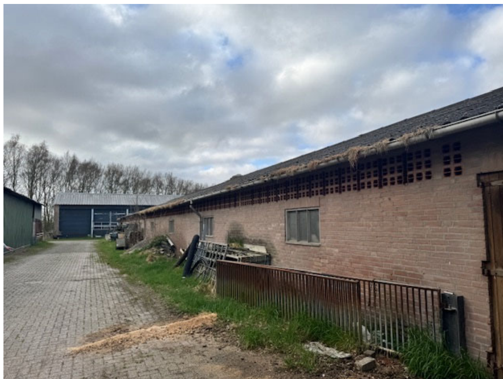
• Afbeelding 13: linker zijgevel te slopen varkensstal, loods op achtergrond blijft behouden
