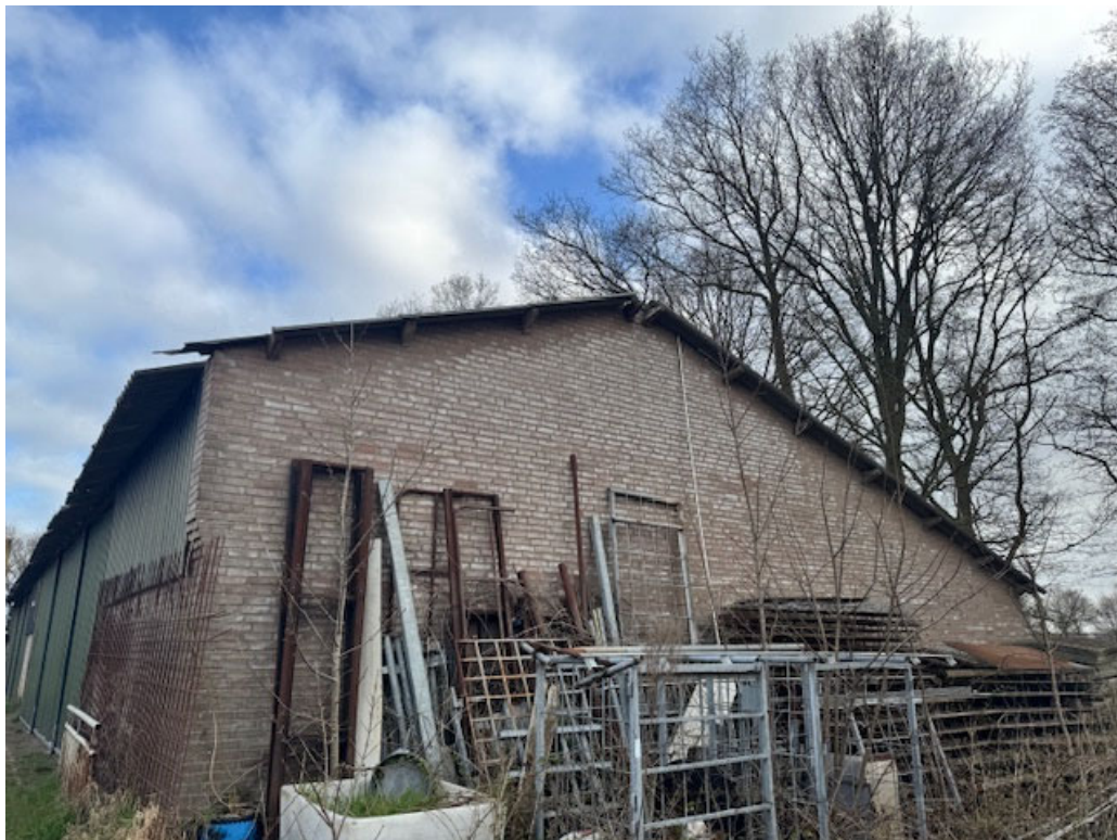
• Afbeelding 17: achterzijde loods die behouden blijft
