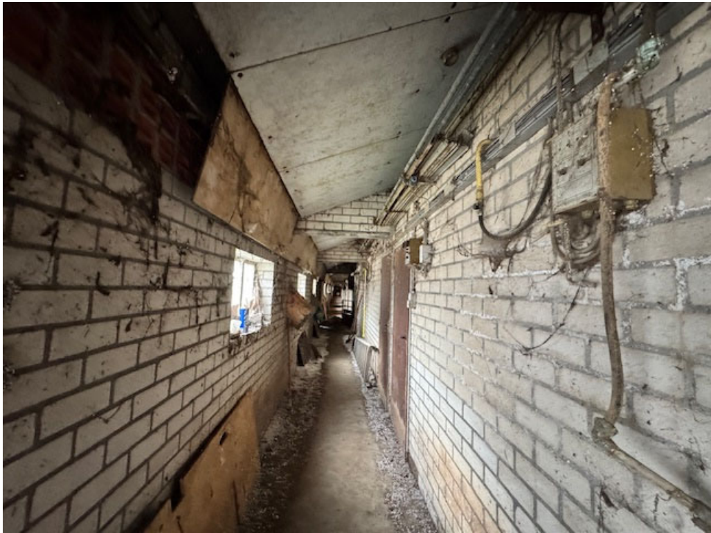
• Afbeelding 16: centrale gang aan de linker zijgevel
