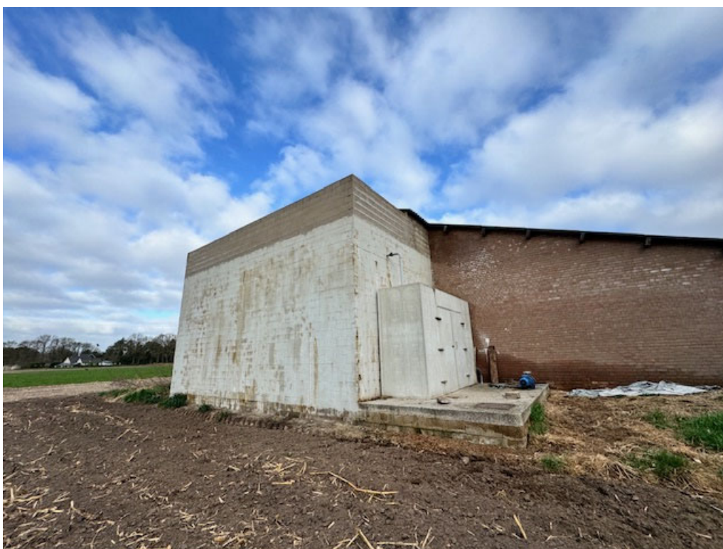
• Afbeelding 27: luchtwasser wordt verwijderd
