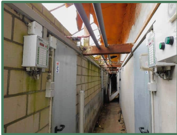
Binnenzijde varkensstal met links gesloopte deel
