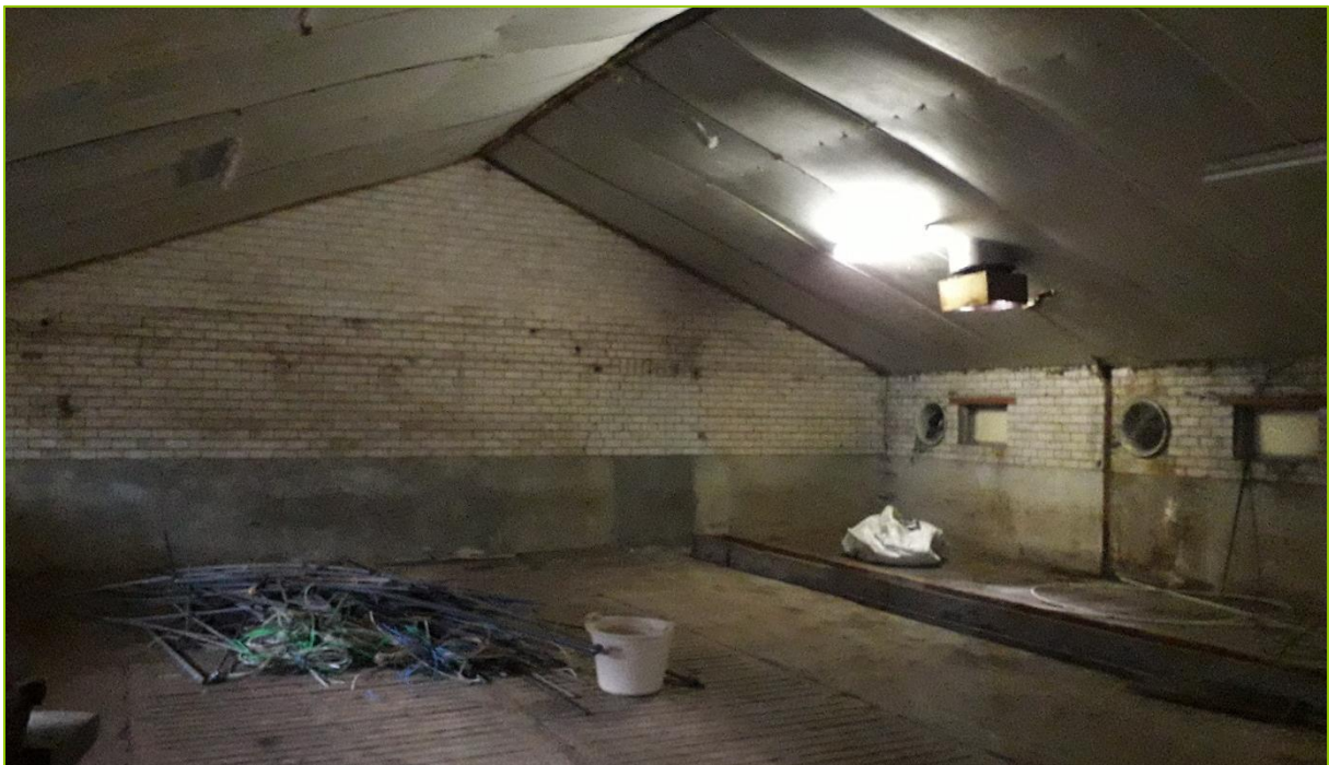
De stallen zijn hermetisch afgesloten afgewerkt en enige tijd niet meer in gebruik.
