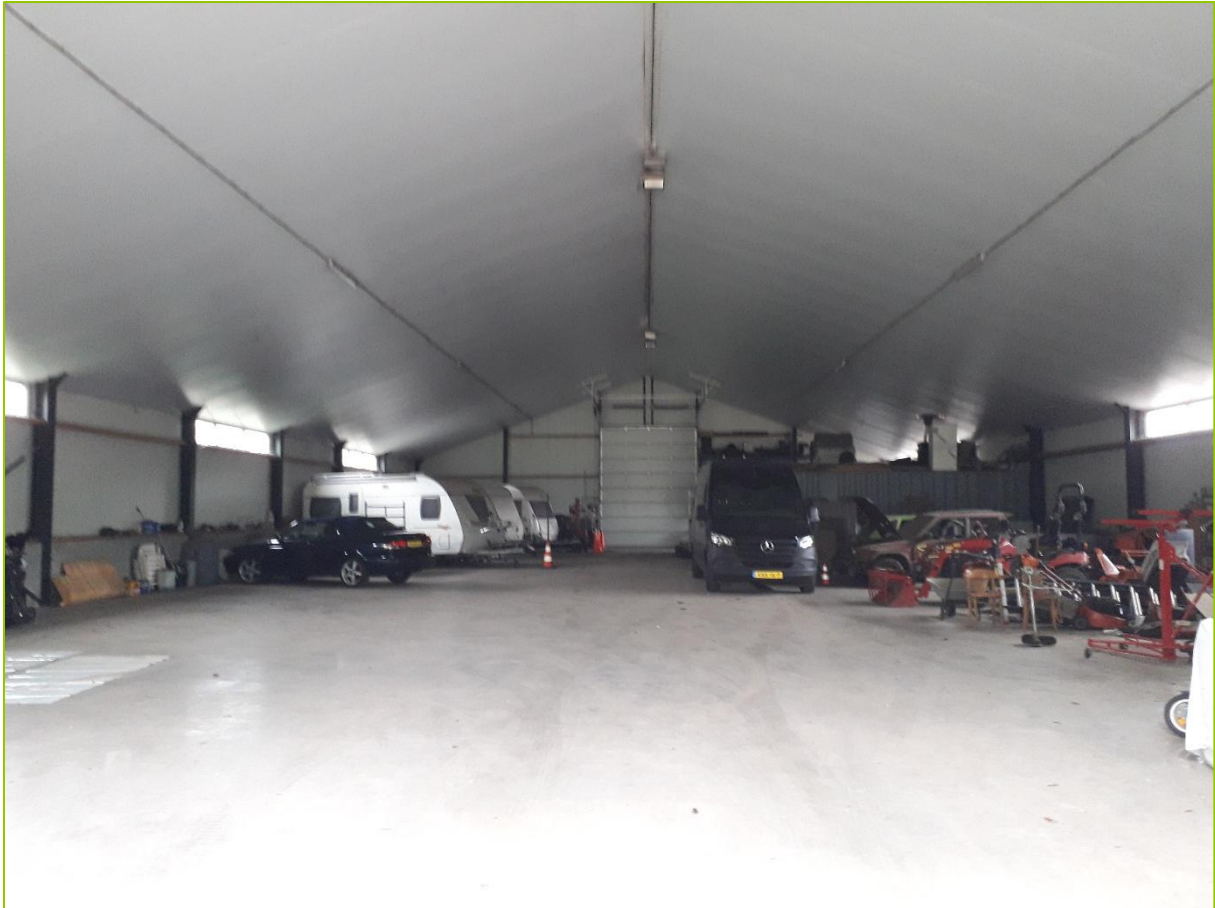
De loods bestaat uit gemetselde gevels (<1m hoog) en damwandbeplating, met een sandwichpanelen dak.
