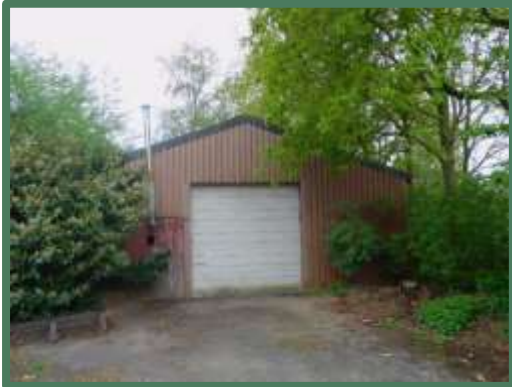
Gebouw met damwandmuur
