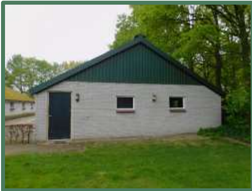
Voorzijde gebouw nummer 8
