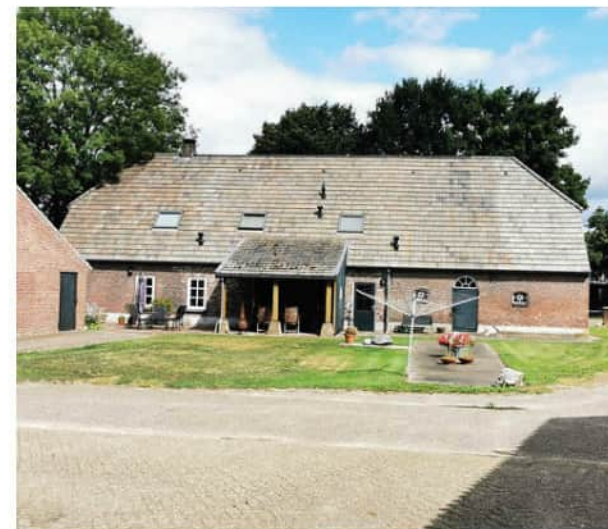
Beeld 5. Achterzijde bedrijfswoning
