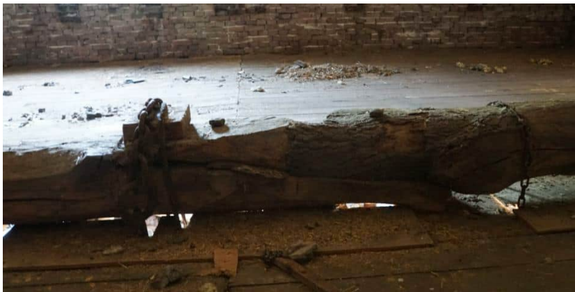
Foto 21: Moerbalk met constructieve verbindingen tussen twee delen dit rust een houten stijler, welke is geplaatst op een betonnen poer ter fundering foto 22.
