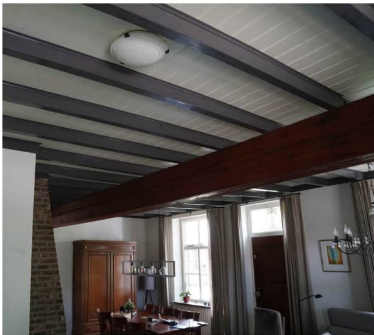
Foto 19: Authentiek balkenplafond, in 2001 gerestaureerd met behoud van oorspronkelijke structuur.
