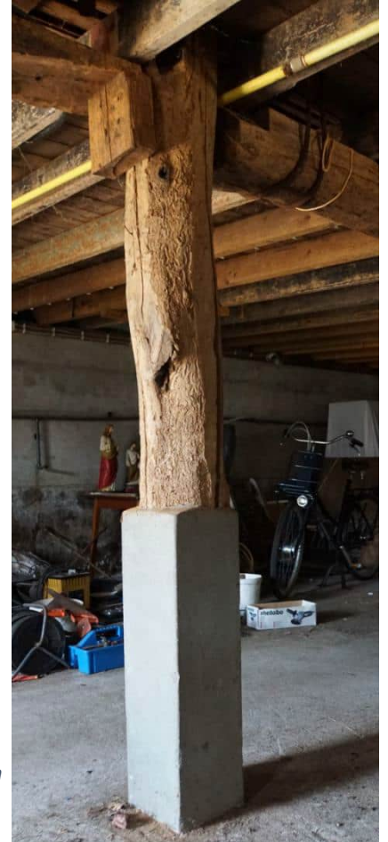
Figuur 22: Houten stijler met betonnen poer
