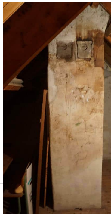
Foto 17: Rookkanaal op zolder voorhuis met originele betonnen luikjes voor trekregeling of rookfunctie.
