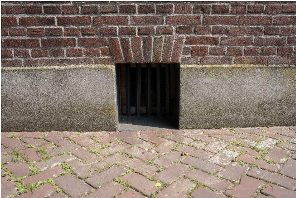
Foto 7: Detail van het kelderraam met dievenspijlen, geplaatst rechtsonder aan de westgevel van de boerderij.
