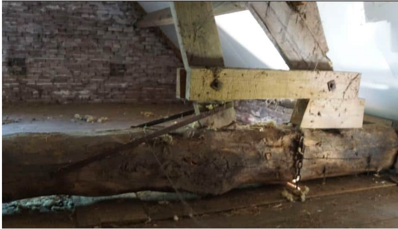
Foto 20: moerbalk met kapconstructie
