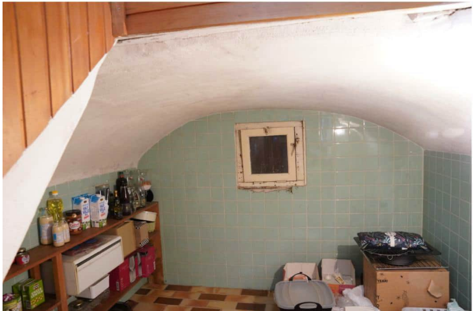
Foto 15: Tongewelfde kelder met goed zichtbare gewelfstructuur en oorspronkelijk kelderraam uit 1914, voorzien van smeedijzeren dievenspijlen aan de buitenzijde.
