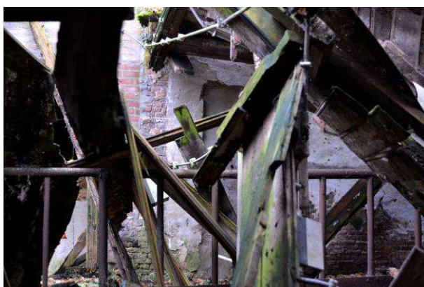
Sporen van een afgebikte muur, gepleisterd muurvlak en deuropening
