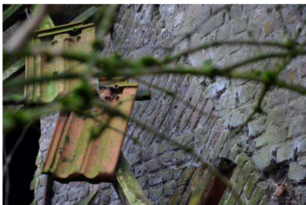
Vlechtingen markeren de oorspronkelijke hoogte van het dak
