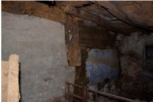
Voormalige voorkamer(s) met gedeeltelijk ankerbalkgebint
