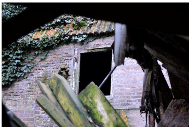
Sparing met kozijn onder de dakrand
