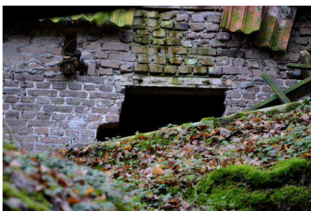
Gedeelte van de sparing rechts in de gevel, onder de dakrand met hergebruikt kozijnstijl
