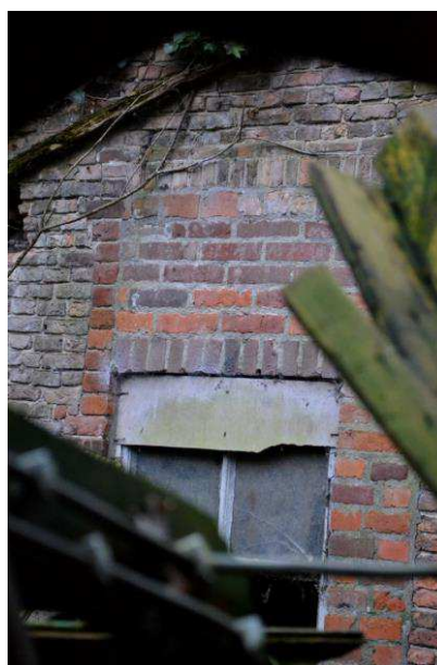
Links: Gevelopening uiterst rechts in de gevel. Rechts: oude deuropening, deels dichtgemetseld en met venster bezet.
