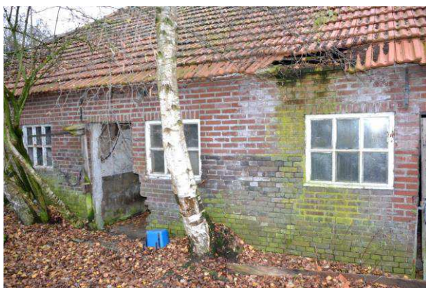
Linkerdeel van de achtergevel. De verhoging van de gevel tekent zich duidelijk af in het metselwerk.
