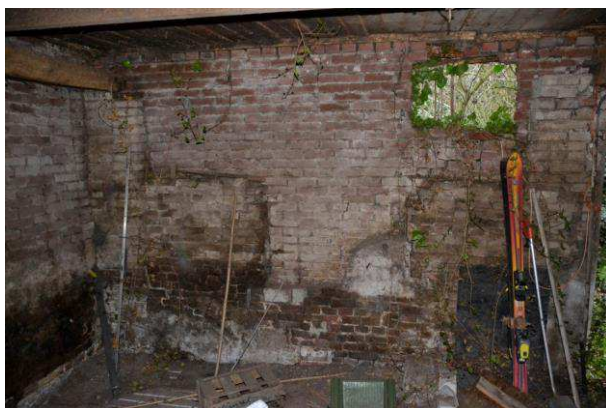
Oud en nieuw metselwerk achterin de vm. boerderij
