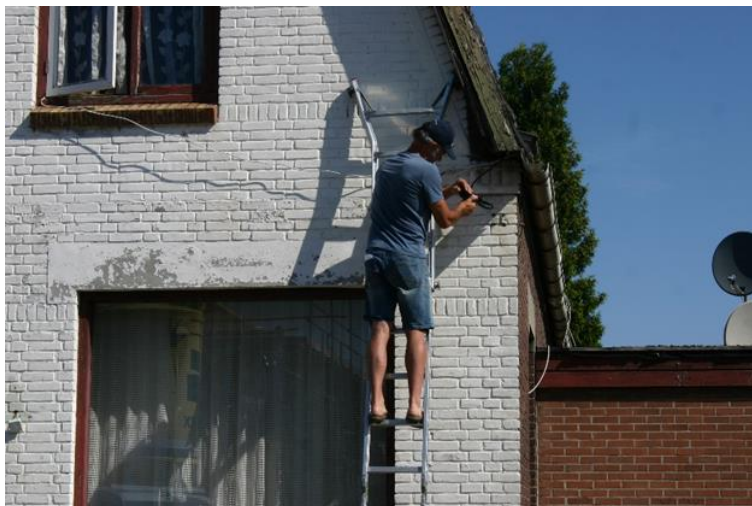
Figuur 4.4.5. Inspectie van het dak van het woonhuis met de boomcamera.
