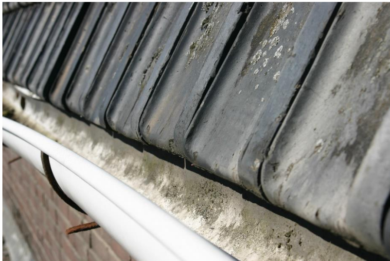
Figuur 4.4.1. Onder de platte dakpannen op het woonhuis is geen ruimte voor vogelnesten.
