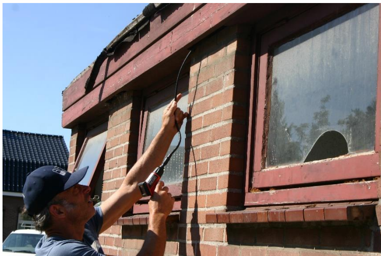
Figuur 4.4.7 Inspectie van de spouw aanbouw woning.
