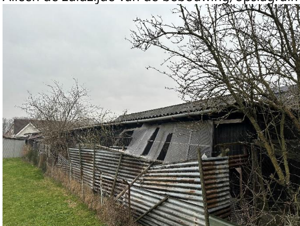
Foto's: zuidzijde opslagruimte
