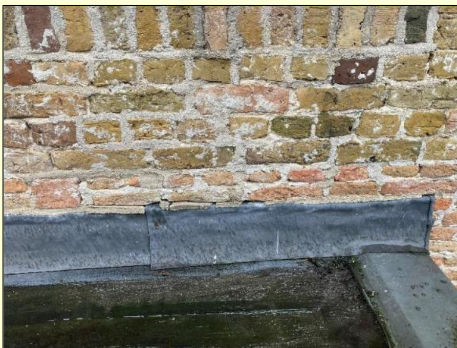
dak no. 8 / gevel no. 3: speciezoom los (foto 2020)
